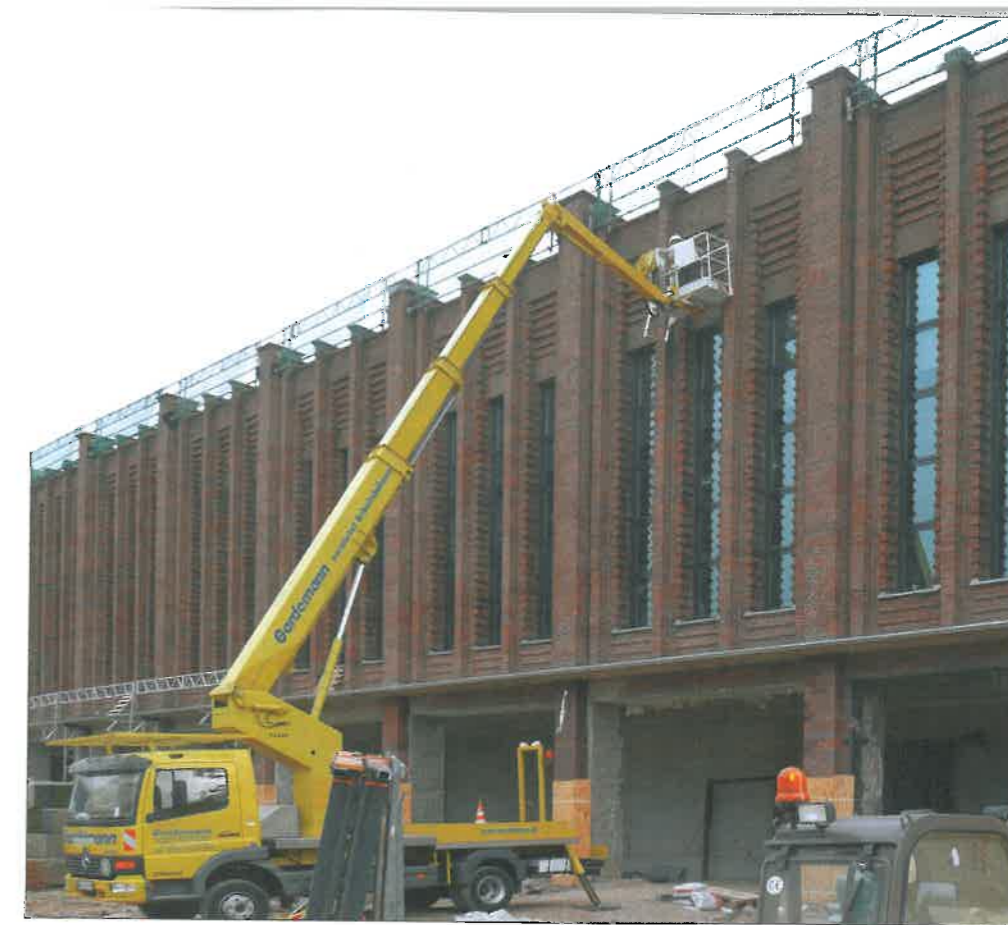
Im Zuge der Umbaumaßnahmen der Kölner Rheinhallen waren 22000 m 2 denkmalgeschützte Fassade zu reinigen.
