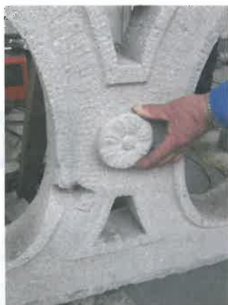
Wiederherstellung einer Rosette als Schmuckelement nach historischem Vorbild
