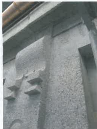
Abgeschlossene Schadstellenreparaturen und Reprofilierung mit Betofix RM
