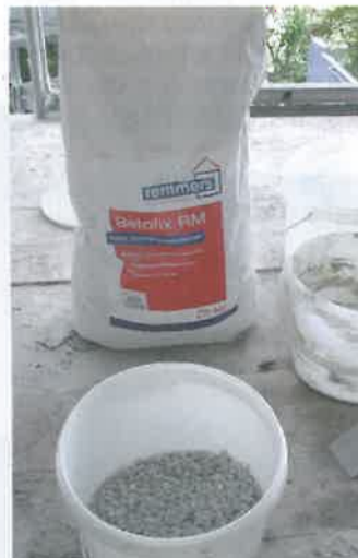
Die Zuschläge und Pigmente für Betofix RM zur Angleichung des Erscheinungsbildes des Bestandsbetons wurden direkt vor Ort zugegeben.
