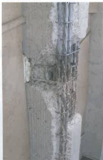
Freigelegte, korrodierte Bewehrungseisen eines Pilasters bis auf eine Tiefe von ca. 20 mm hinter dem Eisen.
