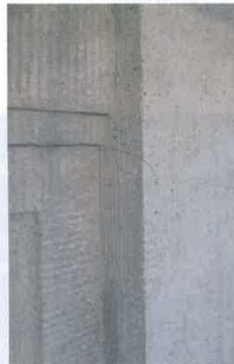
Restaurierte Ausbruchstelle nach steinmetzmäßiger Nachbehandlung (Scharrierung) und Egalisierung durch sanftes Strahlen.
