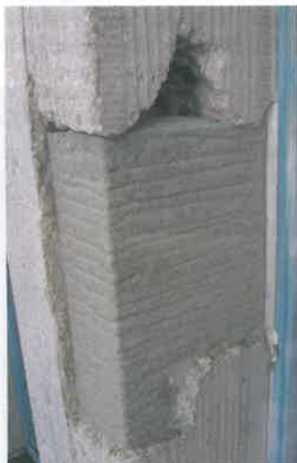
Schichtweiser Auftrag von Vergussmörtel quellfähig, aufräumen der Oberfläche zur Gewährleistung der Kornverzahnung.
