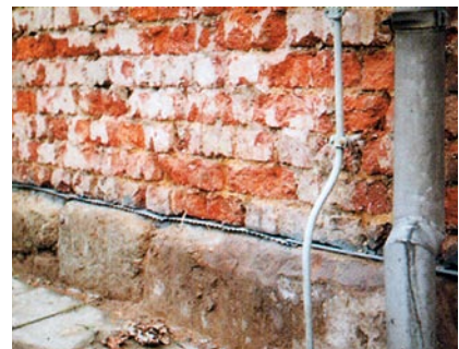
oben: Pfarrhaus in Wernsdorf Chrom-Nickel-Stahlplatten werden durch die gesamte Mauer maschinell eingebracht.
