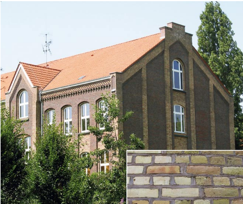
Düsseldorf, Konkordiaschule, nach Farb- entfernung und Klinkerinstandsetzung
