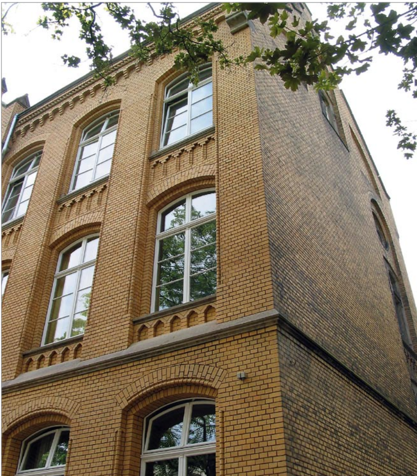
Düsseldorf, Grundschule Florastraße (li. gereinigt und saniert, re. Bestand alt)
