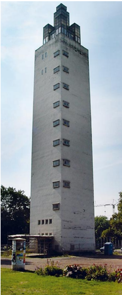
Magdeburg, Aussichtsturm Rotehornpark vor der Ausführung
